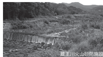
蔵王川流域火山砂防施設
