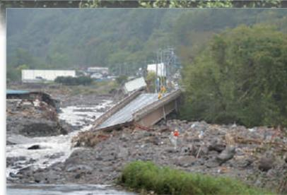
台風 19 号により崩壊した鳴岩橋
