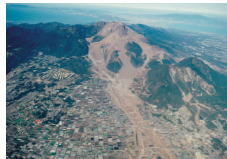
土石流による被害(1991,7,1)
