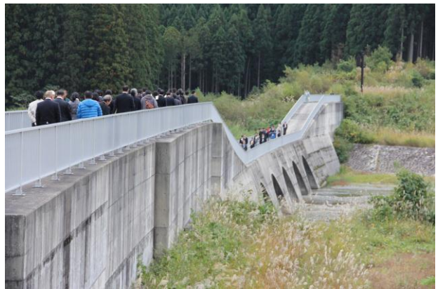
図 5.4 生保内川 大暗渠砂防堰堤
